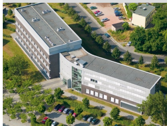
UFZ premises in Magdeburg, Brückstraße 3a
